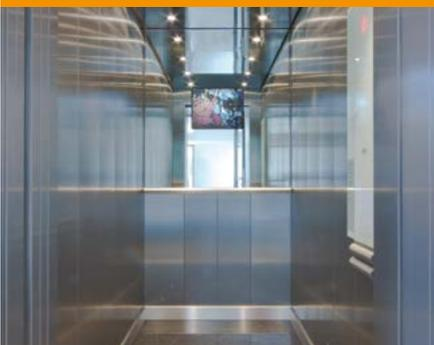
**Aufzugstyp 1, 2 und 3** müssen mit einem Spiegel oder einer ähnlichen Anbringung ausgestattet sein, die das Erkennen von Hindernissen bei Rückwärtsfahren mit Rollstühlen ermöglicht.
